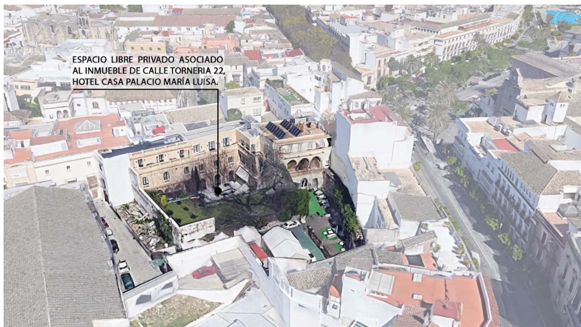
Imagen de localización del patio perteneciente a la Finca de Calle Tornería 22.
